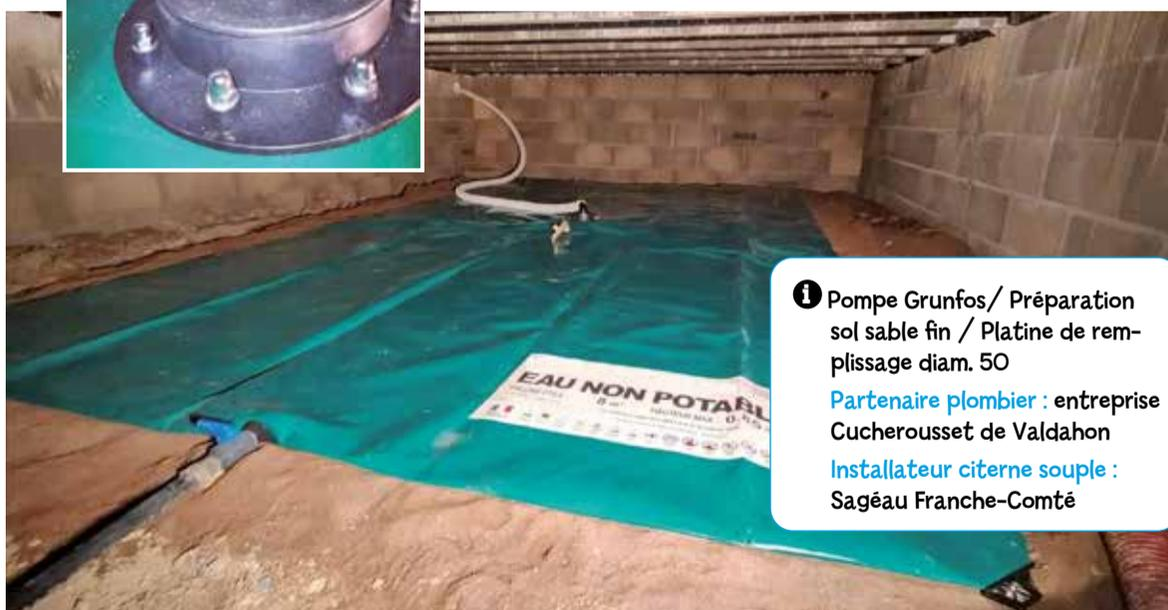
**i** Pompe Grunfos/ Préparation sol sable fin / Platine de remplissage diam. 50
